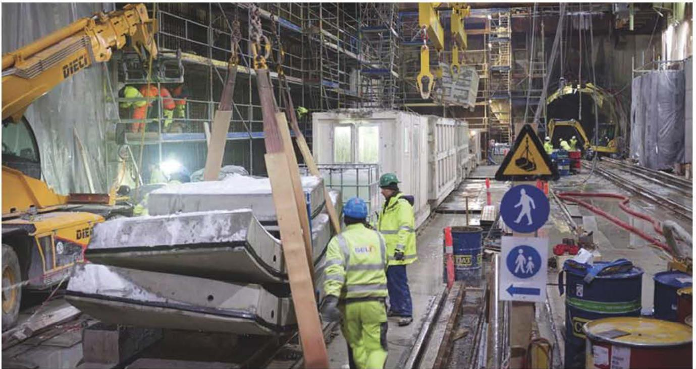
las TBM requieren asistencia continua y esmerada para su puesta en funcionamiento, repostaje o sustitución de piezas importantes: en esta tarea han participado los Pegasus, que ya se habían utilizado anteriormente en otras grandes obras, como las nuevas líneas del metro de Milán o el túnel del Brennero. Los 37 km de túnel realizados con las TBM han sido recubiertos con toneladas y toneladas de cemento, intervención de consolidación de
